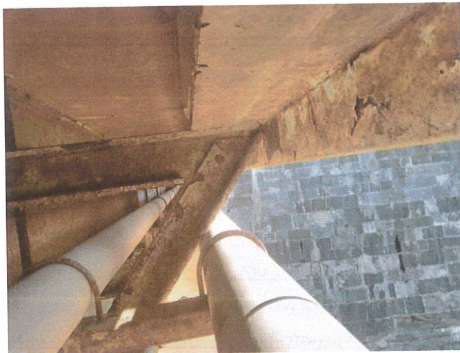
Εικόνα 48 : Η στήριξη διέλευσης των ηλεκτρομηχανολογικών αγωγών στην δευτερεύουσα κατασκευή.
