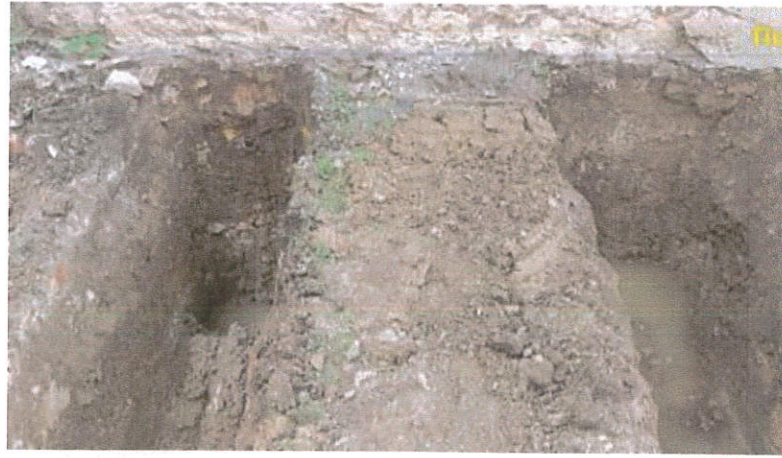
Εικόνα 34 : Εκσκαφή στα θεμέλια του 2ου βάθρου
