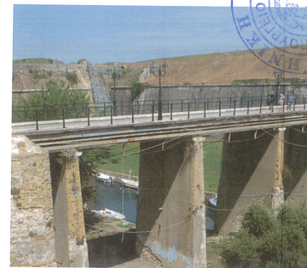
Εικόνα 33 : Ο μεταλλικός φορέας μετά από την ολοκλήρωση των εργασιών ενίσχυσης.
