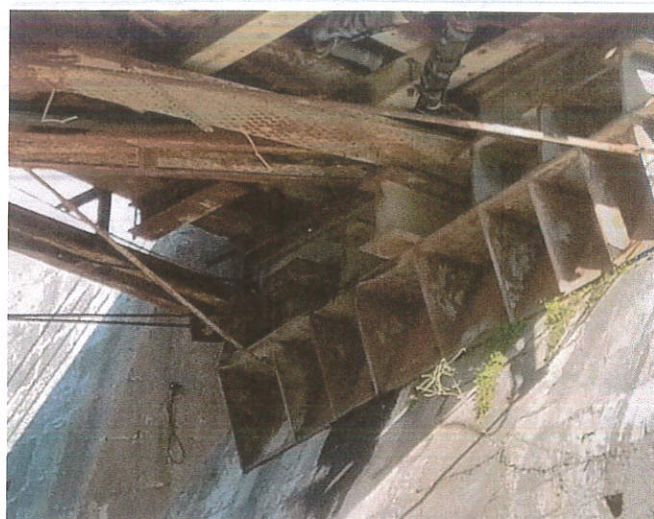
Εικόνα 42 : Η έδραση του φορέα της γέφυρας στην τοιχοποιία του κρημνού.
