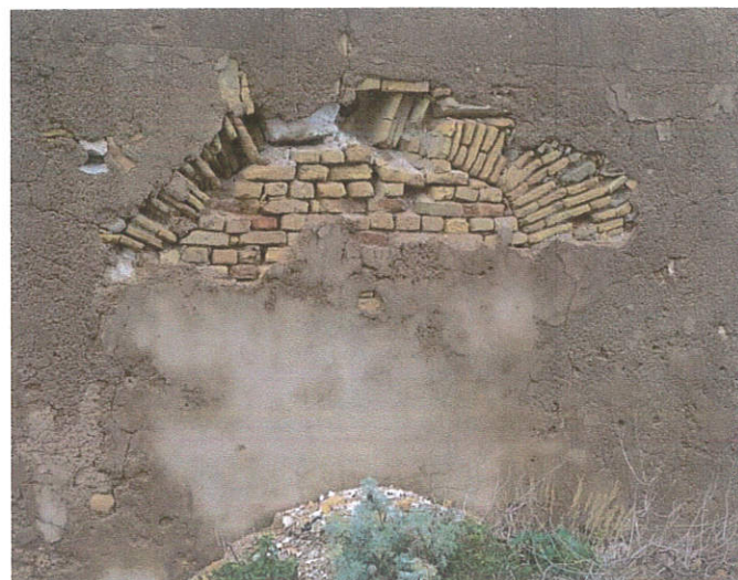
Εικόνα 38 : Το τοξωτό πρέκι από οπτόπλινθους του φραγμένου ανοίγματος. Εικόνα 39 : Τα λίθινα φουρούσια.
