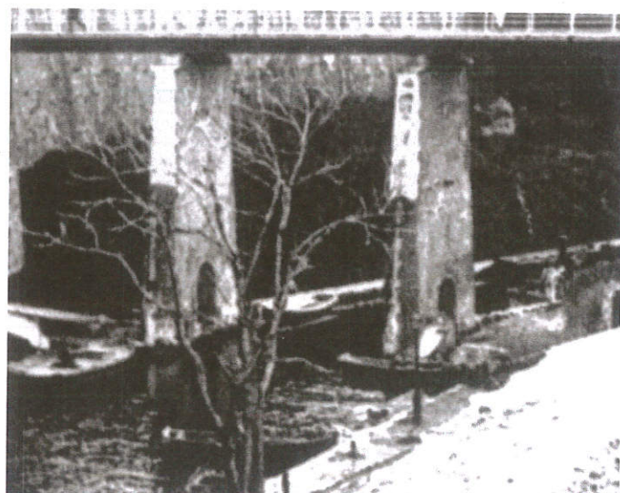
Εικόνα 30 : Ανοίγματα στη βάση του 3ου και 4ου βάθρου. Εικόνα 31 : Άνοιγμα στη βάση του 4ου βάθρου.
