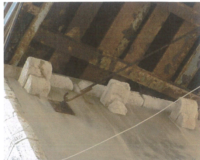
Εικόνα 38 : Το τοξωτό πρέκι από οπτόπλινθους του φραγμένου ανοίγματος. Εικόνα 39 : Τα λίθινα φουρούσια.
