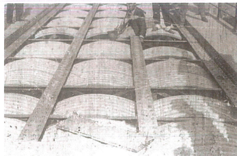
Εικόνα 26 : Τα διαδοχικά οικοδομικά στοιχεία του μεταλλικού φορέα του νέου καταστρώματος.
