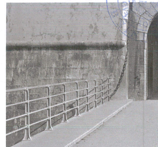
Εικόνα 27 : Το μεταλλικό κιγκλίδωμα της γέφυρας και η παλιά αλυσίδα.
