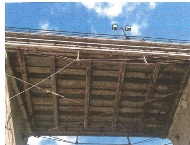
Εικόνα 40 : Ο μεταλλικός φορέας του φατνώματος. Διακρίνονται οι εγκάρσιες και οι οριζόντιες δοκοί καθώς και το σύστημα άντωσης των δοκών όπου στηρίζονται οι ηλεκτρομηχανολογικές υποδομές.
