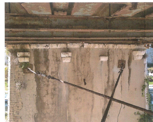
Εικόνα 29 : Ο αρχικός μεταλλικός συνδετήρας και οι νεότερες χιαστί χαλύβδινες ράβδοι.
