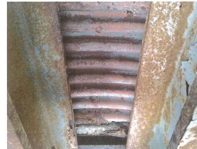
Εικόνα 41 : Η αψιδωτή κυματοειδής λαμαρίνα πάνω από τις διαμήκεις δοκούς.
