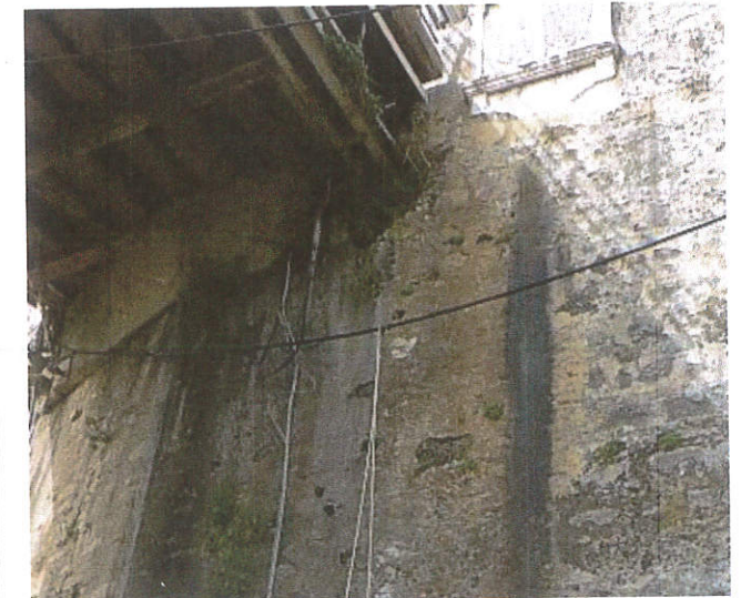
Εικόνα 51 : Η υπόβαση σκυροδέματος για την έδραση της γέφυρας στην τοιχοποιία του αντικρημνού.
