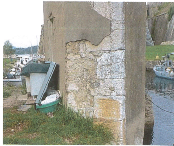
Εικόνα 35 : Η τριγωνική λίθινη απόληξη του βάθρου και η επικάλυψη με τσιμεντοκονία.
