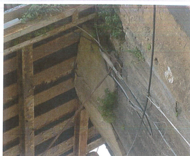
Εικόνα 43 : Η έδραση του φορέα της γέφυρας στην τοιχοποιία του αντικρημνού.
