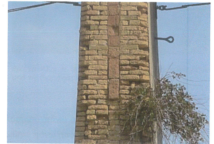
Εικόνα 37 : Το πάνω τμήμα των βάθρων προς τη νότια πλευρά με οπτόπλινθους και την κατακόρυφη διαφοροποίηση των κάθετα τοποθετημένων κόκκινων οπτόπλινθων.
